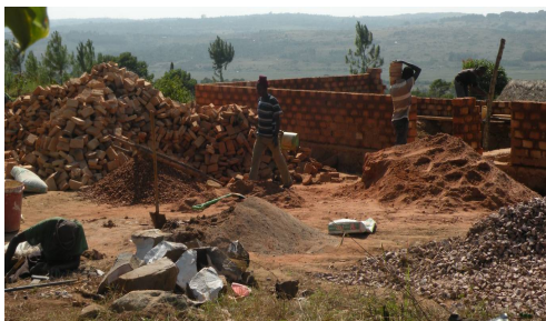
DCC Neema im Bau
