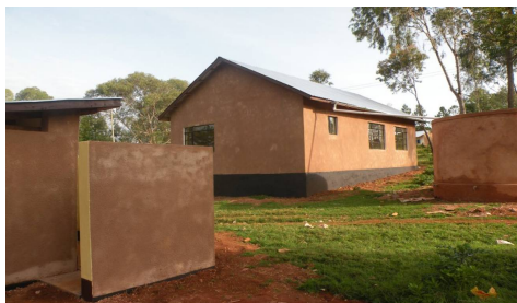
DCC Kahumulilo: Toiletten, Hauptgebäude, Wassertank
