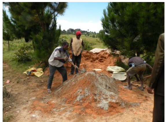
Beim Bau eines neuen DCCs (2009)
