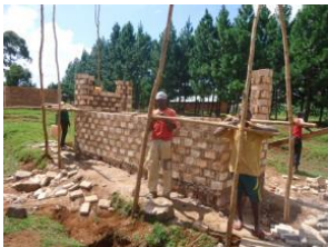
Baubeginn im Oktober 2015
